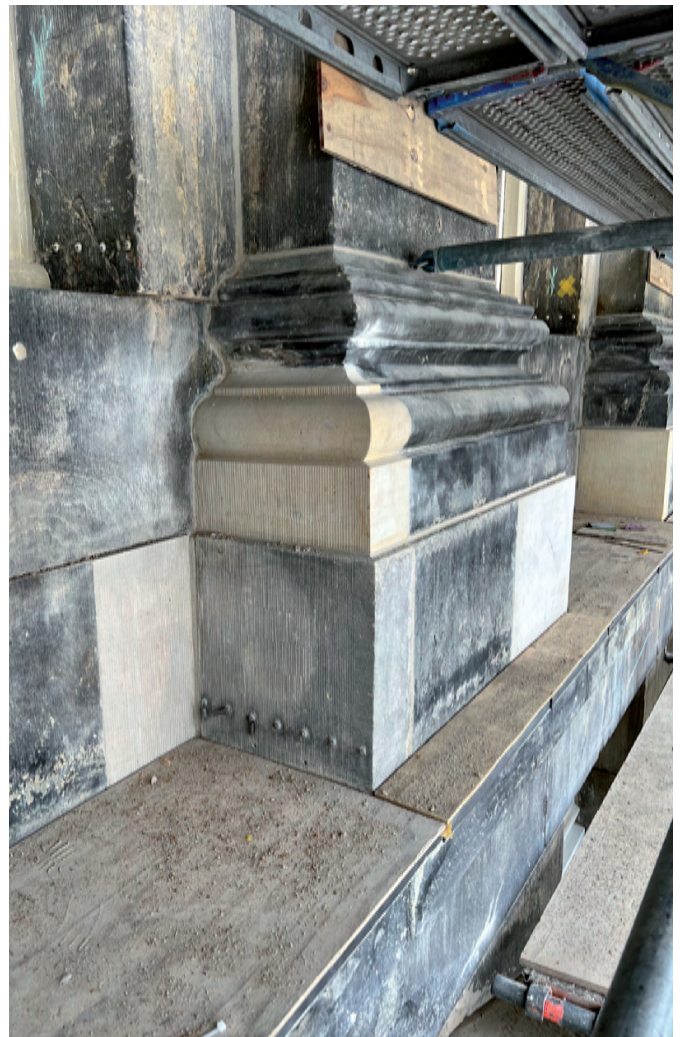
Basement in de gevel met nieuw ingezette reparatieblokken van Bentheimer zandsteen (Erfgoed 's-Hertogenbosch, foto Ronald Gludemans).
