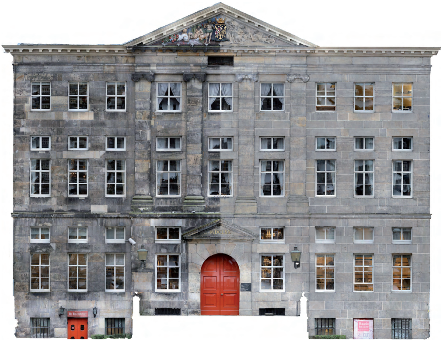
Fotogrammetrische projectie van de voorgevel van het stadhuis, voor de helft digitaal schoongemaakt om te onderzoeken welk resultaat het voorgenomen 'ontstoren' zou gaan opleveren (Erfgoed 's-Hertogenbosch, foto Jan Viguurs, bewerking Ronald Glaudemans).
