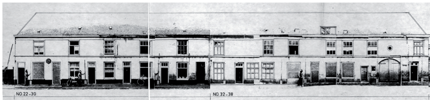
Figuur 5. Achter in de Schilderstraat een blokje van negentien gangwoningen met een gezamenlijk privaat (eerste deur links). Gefotografeerd voor 'Gevelwanden', een overzicht van Bossche straatwanden, oktober 1974. 13
