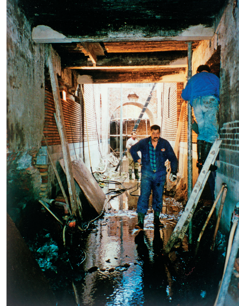
Restauratiewerkzaamheden onder en aan de Synagoge in de Prins Bernhardstraat (1994). (Foto: Stadsarchief)
