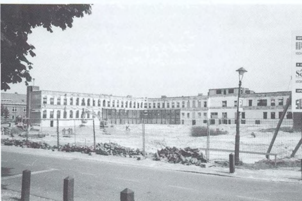
Het H.T.S.-gebouw na sloop van de latere toevoegingen. Duidelijk zichtbaar zijn de oorspronkelijke gevels aan het bin- nenterrein. Foto vanaf de Van der Weeghensingel. (Foto: BAM)
