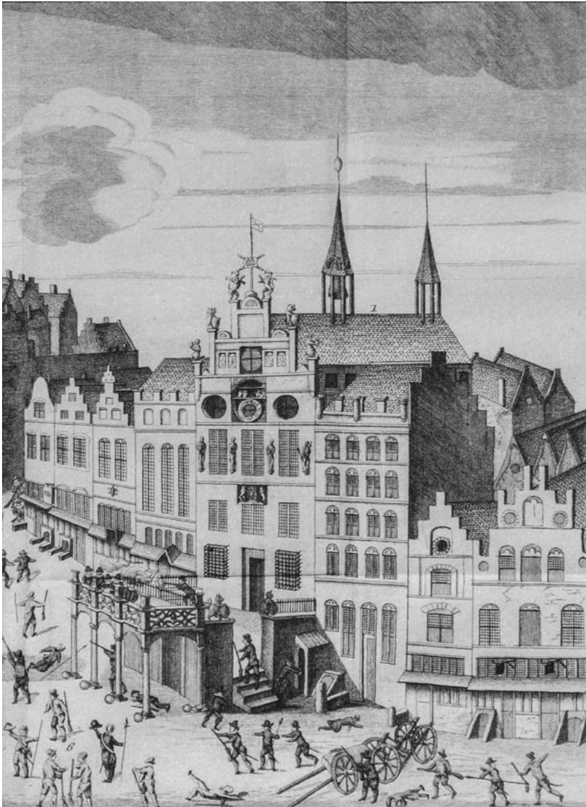
8. Het stadhuis (Markt 1, midden) van 's-Hertogenbosch aan de Markt, eind zestiende eeuw. De opbouw van het bordes voor het stadhuis is goed zichtbaar. Rechts naast het bordes in de hoek met het pand Markt 1 rechts is de toegang zichtbaar van de poortweg van Lysscepe om zijn achtererf te kunnen bereiken. Detail van het rechtergedeelte van een gravure door G.J. de Huyser uit 1776 van het Schermersoproer in Den Bosch uit 1579, naar een schilderij van Jan van Diepenbeek (1573-1621). Vermoedelijk geeft de gravure de situatie weer van het stadhuis iets na het oproer van 1579. (Gravure in bezit van auteur; schilderij collectie Noordbrabants Museum, 's-Hertogenbosch)
