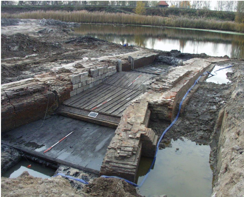
De volledig vrijgelegde sluis, gezien in westelijke richting. Op de achtergrond het restant van het vroegere Wiel en daarachter de spoorlijn 's-Hertogenbosch – Utrecht. (foto: BAM)
